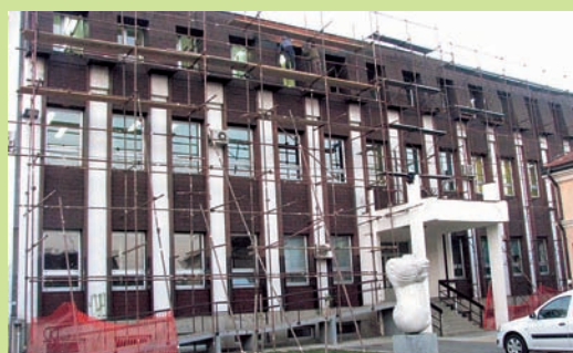
Реконструкција крова на згради Стоматологије
